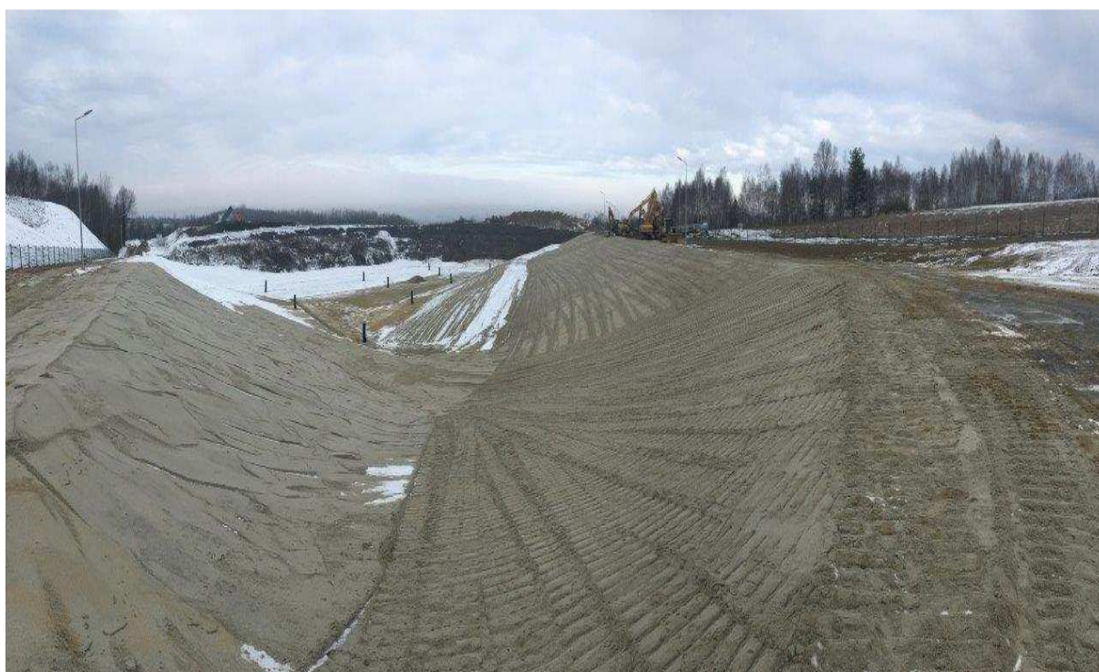
Zdjęcie 4. Rozbudowa składowiska odpadów
