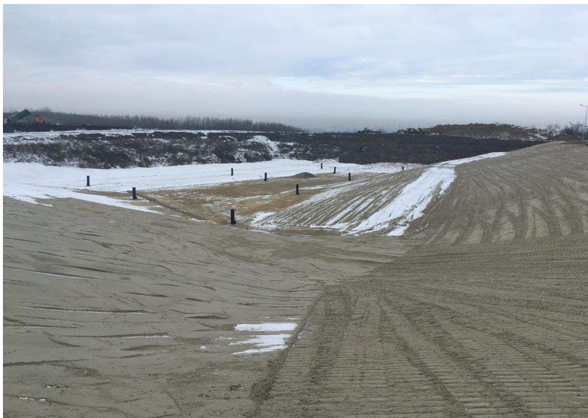
Zdjęcie 3. Rozbudowa składowiska odpadów
